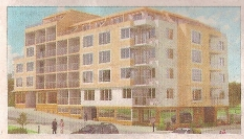
Във вертикално отношение жилищната част е решена на шива, съобразни с наклона на терена, при спазване на допустимата височина на застрояване
